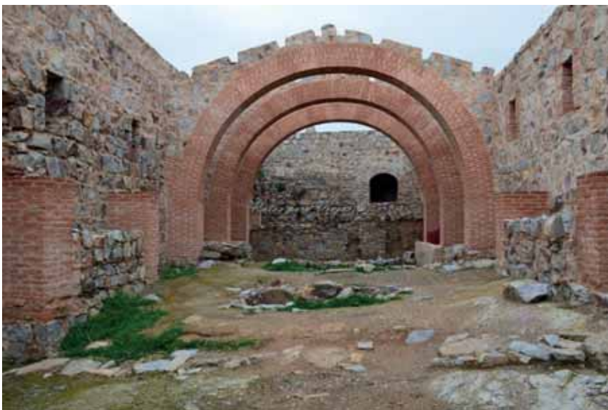
Fig.3: La tahona del Convento tras la restauración. Fotografía de 19-03-2015
