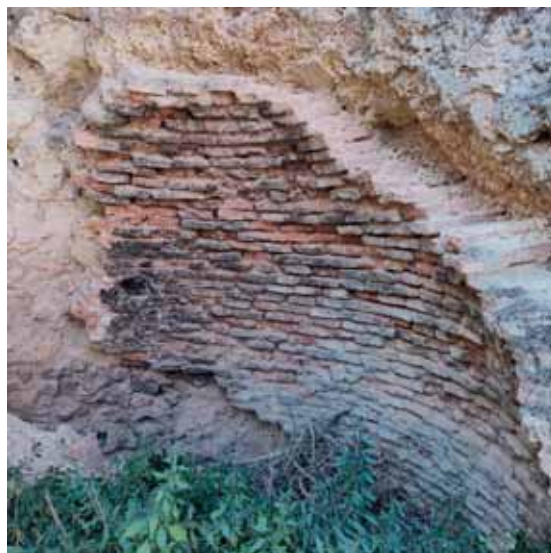
Figs. 7-8: Tahona del Monasterio de Uclés y detalle del muro interior del horno) 01-08-2021
